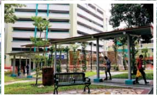
Covered linkway from Blk 280 to 283 Bukit Batok East Ave 3 (Bukit Batok East)
